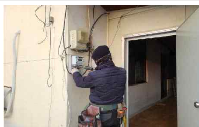
<개별 전력량계 설치>
